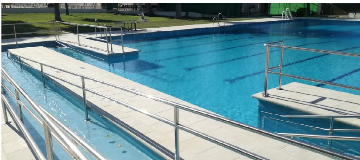
Imagen de la piscina después del llenado
